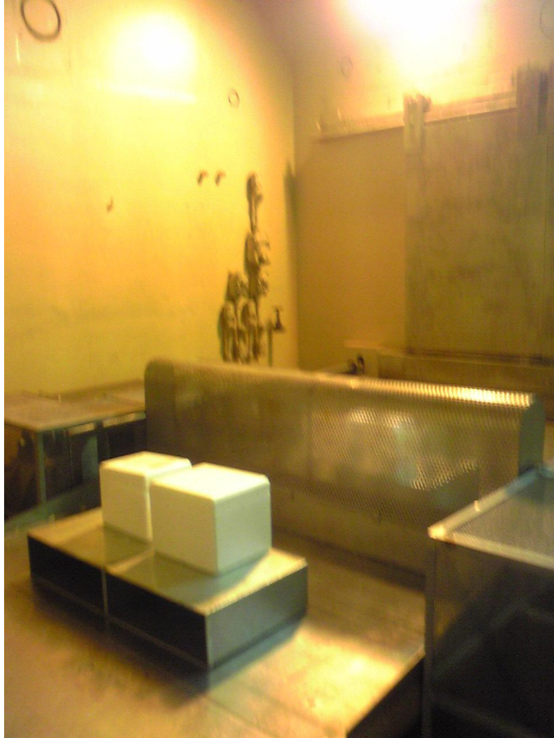
日本原子力研究開発機構 高崎量子応用研究所 ガンマ線照射施設 コバルト2棟 第7照射室
